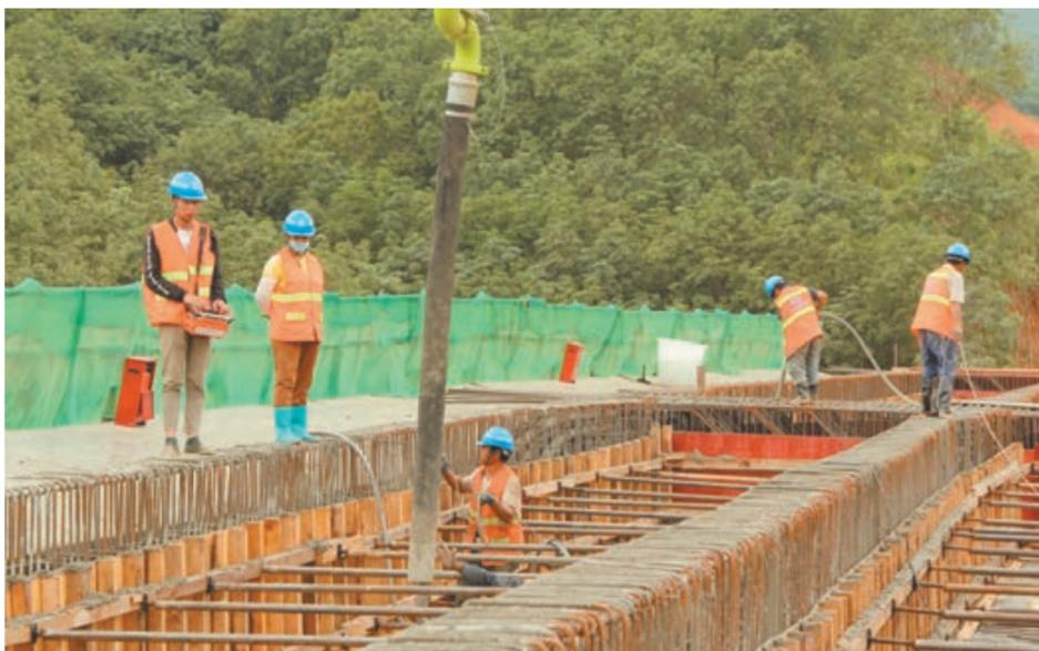
在第一施工总承包部三分部, 承担专业分包的忙海河特大桥施工现场, 运输混凝土的罐车有序出入, 机械轰鸣, 施工作业人员各司其职, 一派有序的忙碌景象。随着最后一方混凝土入模, 左 11 号主墩顺利封顶浇筑完成。该桥为永勐高速公路三个控制性工程之一, 也是永勐高速公路全线三座连续钢构桥之一, 设计全长 1096 米, 最大墩高 100 米, 主跨长 120 米, 主梁设计为 65+120+65 米, 采用挂篮悬浇施工, 主梁结构尺寸复杂、技术含量高、施工难度大, 此次完成浇筑的左 11 号墩为最高墩柱。在军赛段迎庆河大桥施工现场, 施工作业人员正在对大桥混凝土体量 860 立方米的现浇箱梁进行最后的收尾浇筑及首片预制 T 梁架设施工作业。
