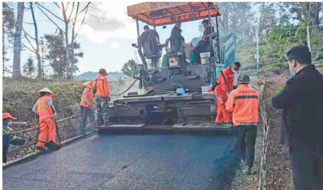
为持续推进沿边小康村建设,加快构建沿边路网系统,近日,沧源佤族自治县勐董镇龙乃村完成了上龙乃永舍自然村至边防巡逻道路1公里柏油路铺设工作,实现了村组道路柏油路的目标。既方便群众出行、农特产品出山,为群众铺上了产业致富路,又畅通边防巡逻道,为抵边群众守好边境防线奠定基础。图为道路施工现场。 赵乐乐 摄
