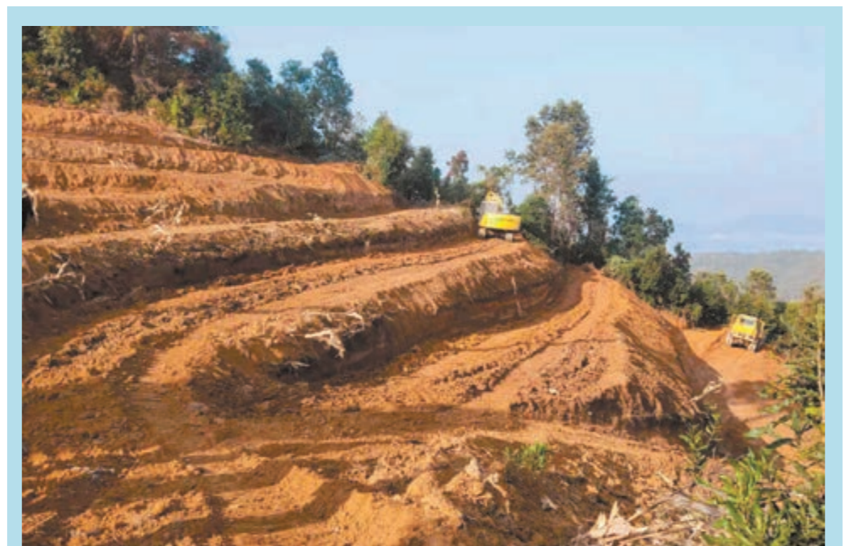
永德县永德镇充分发挥政策推动、宣传发动、大户带动、坡改梯促动“四大动能”,力推糖料蔗核心基地建设,着力做到“基地建好一块,甘蔗种好一块”。目前,全镇共完成坡改梯土地面积1350亩,累计种植甘蔗1100亩;完成工业入榨量5100吨,实现工业产值214万元。4万亩糖料蔗核心基地建设后,预计可带动农户增收1亿元。图为机械化坡改梯现场。
