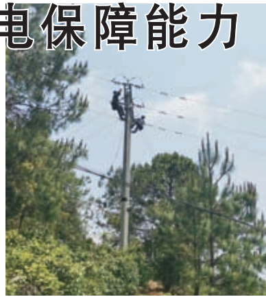
图为电力工人在开展线路检修。
