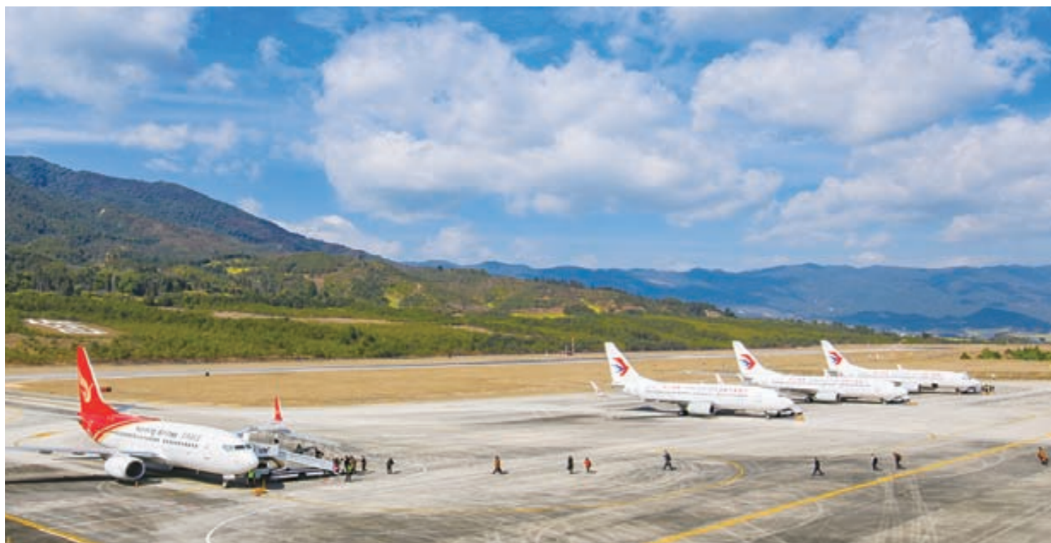
改扩建后的临沧机场
