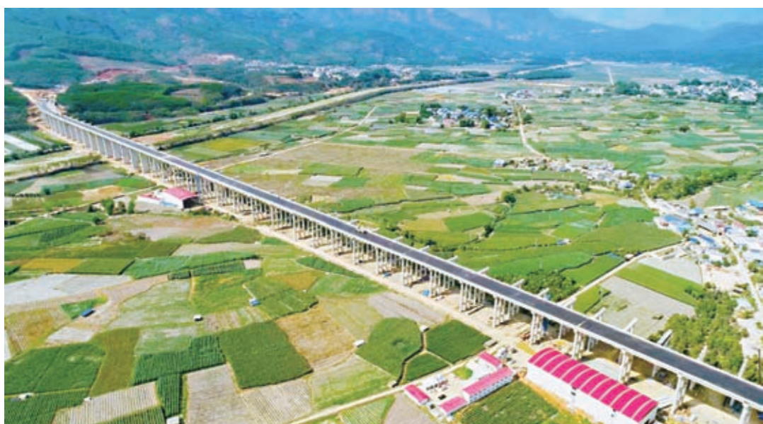
永勐高速跨南汀河大桥
