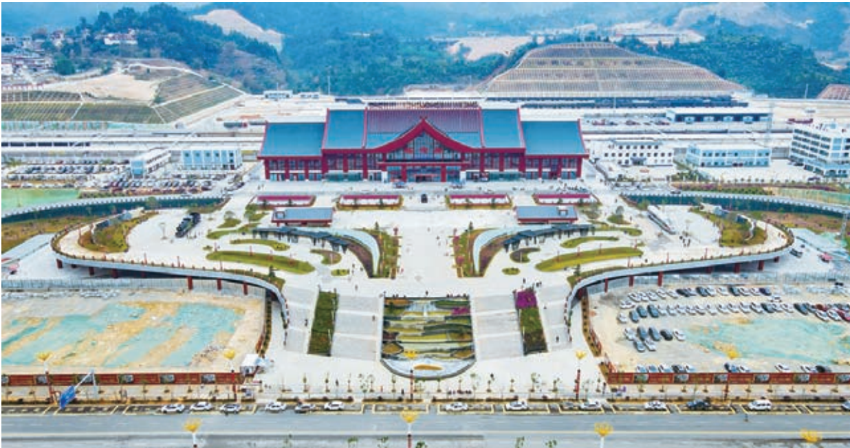
大临铁路建成通车,实现了临沧百年铁路梦。图为临沧站。
