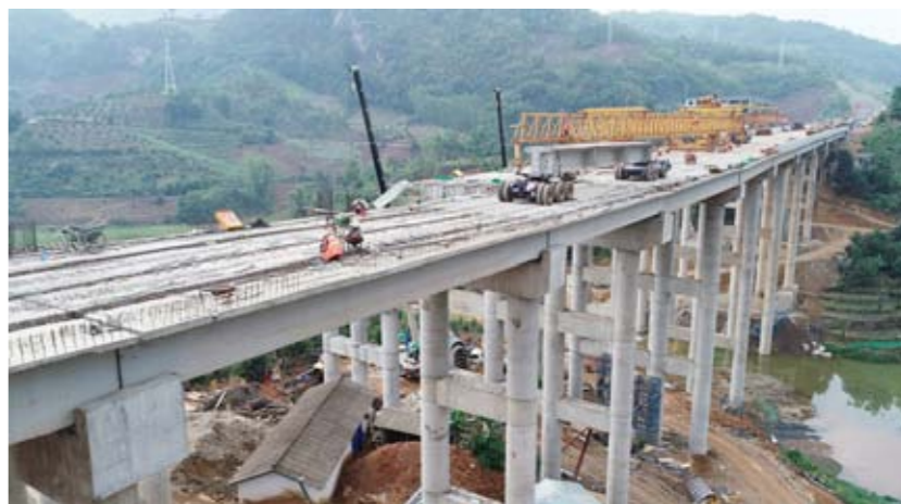
建设中的临清高速公路
