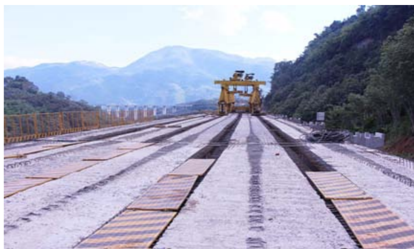
建设中的镇清高速公路
